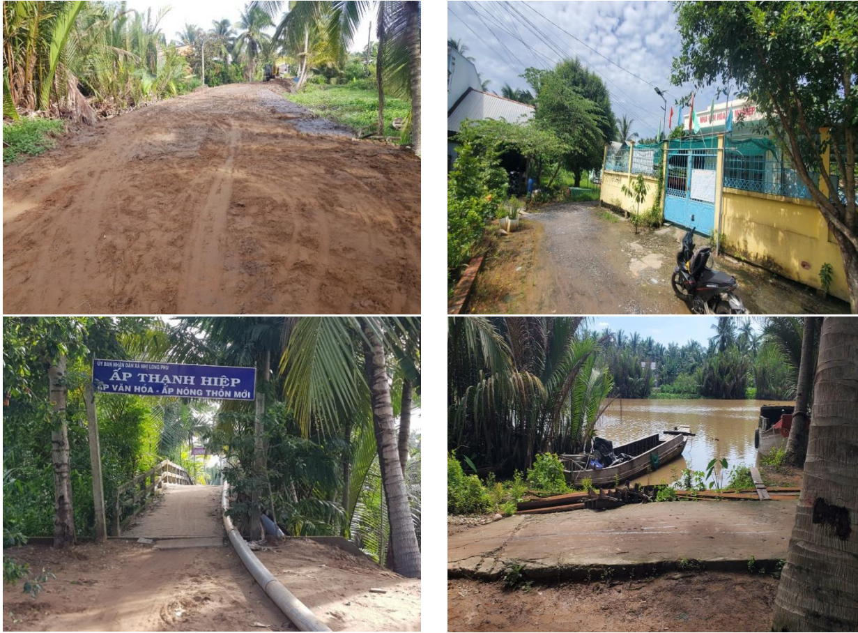
Hình 2. Một số hình ảnh hiện trạng khu vực thực hiện Dự án
